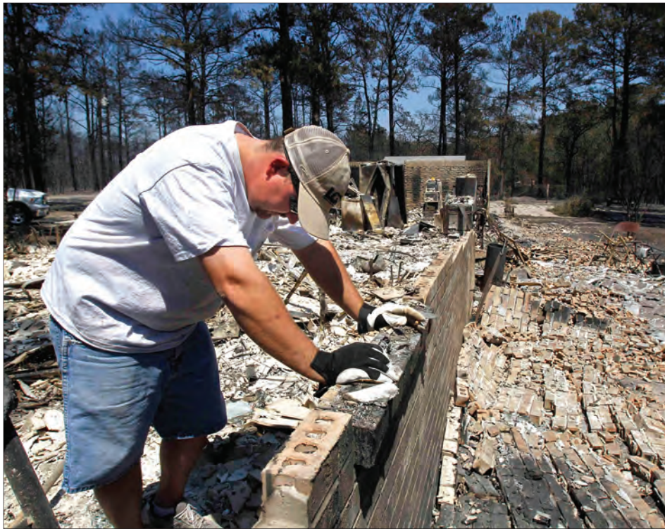
Eric Kemper toma un momento para componerse el 6 de septiembre mientras revisa los escombros que quedan de su casa después de ser destruida por los incendios forestales que siguen fuera de control cerca de Bastrop, Texas. Por lo menos dos personas han muerto en los incendios, que han destruido más de 700 hogares y han ennegrecido aproximadamente 45 millas cuadradas alrededor de Bastrop, una ciudad cerca de Austin, la capital del estado. (Foto CNS / Mike Stone, Reuters)
